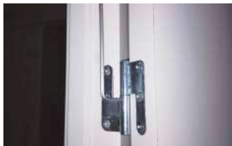
Regulacja wysokości roboczej drzwi wewnętrznych - klucz imbusowy
