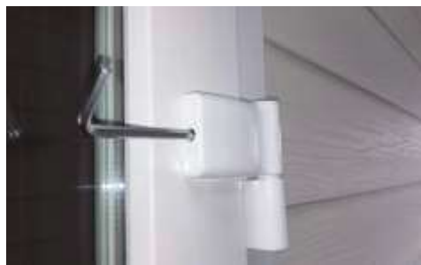
Regulacja pozioma zawiasów drzwi wejściowych - klucz imbusowy.
