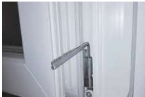
Regulacja pionowa okna - klucz imbusowy
