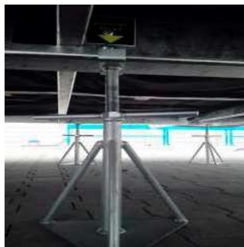
Podpora niska służy do podparcia podłużnic w okolicach osi
