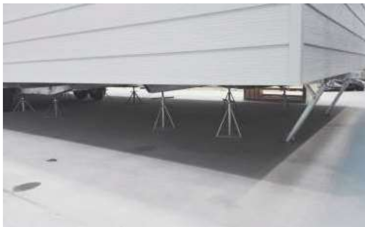
Na zdjęciu poniżej przedstawiono widok na prawidłowo podparty dom z wykorzystaniem 16 podpór regulowanych (po 8 sztuk na stronę) i z rozłożonymi podporami krańcowymi (stabilizatorami)
