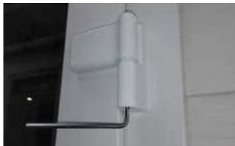
Regulacja pionowa drzwi wejściowych - klucz imbusowy
